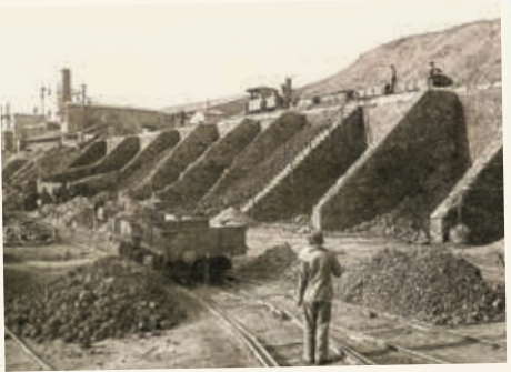
Βαγονέτα πάνω από τις υπαίθριες αποθήκες, έτοιμα να ξεφορτώσουν το μέταλλευμα Mine waggons on top of the open-air warehouses, ready to unload the ore
